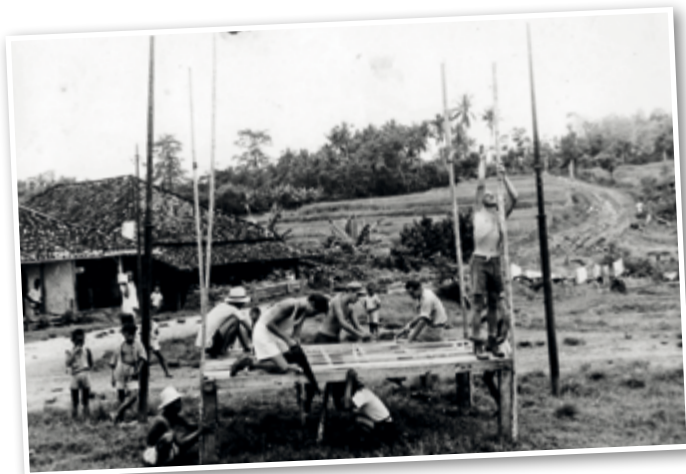
Met het herstellen en aanleggen van wegen en bruggen wordt de burgerbevolking geholpen
