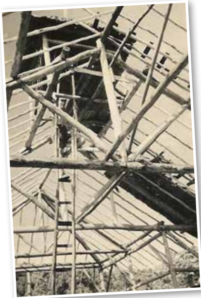
Timmerwerk aan de bouw van een opslagloods. Het grondproduct: hout, is in voldoende mate aanwezig.
