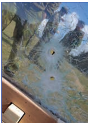
2 x uitschot van .338 vanaf 300 meter op dubbelglas.
