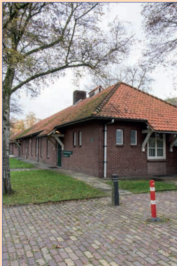
Hier begon het allemaal: het inmiddels gesloopte stafgebouw 25 op de Generaal-majoor de Ruyter van Steveninckkazerne. Deze laagbouw gebouwen zijn tussen 1946 en 1950 gebouwd. Hier het raam van het bureau van de Regimentscommandant.
