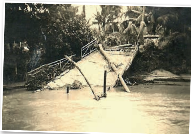
Foto D. Smits: Opgeblazen brug
