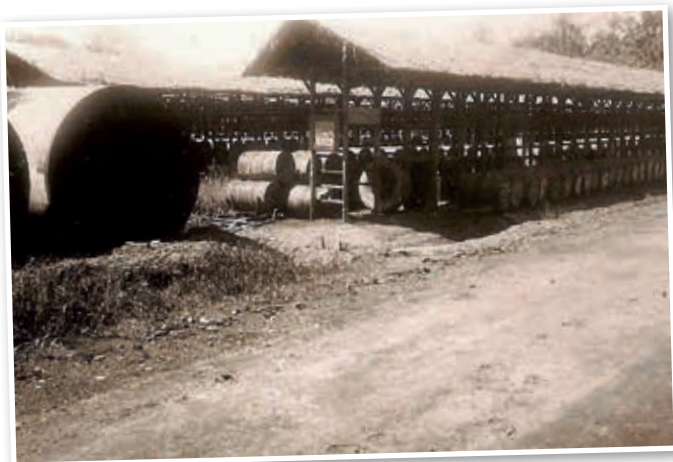
Foto P. Buijze: Olieopslagplaats van de NNGPM.
