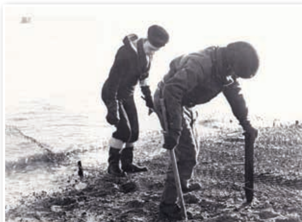
De Britse kust 1943/1944: Oefeningen met de Britse Marine. Gaasmatten worden vastgezet op het strand, zodat voertuigen en motoren gemakkelijker door het zand kunnen rijden vanaf de landingsvaartuigen.
