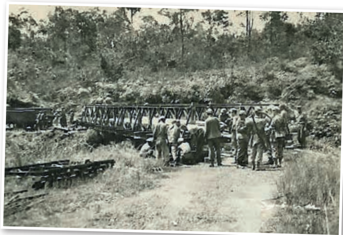
Brug- en wegherstel
