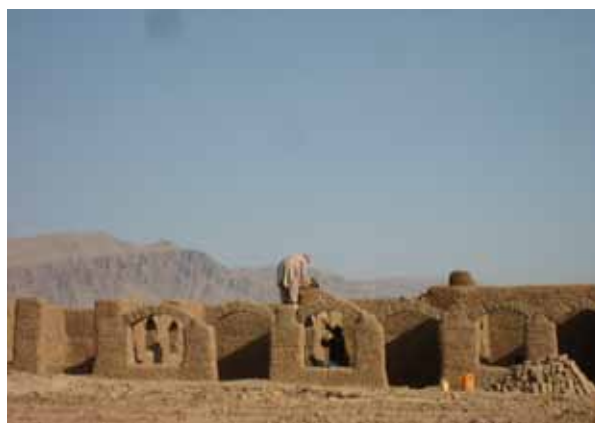
Een qala in aanbouw
