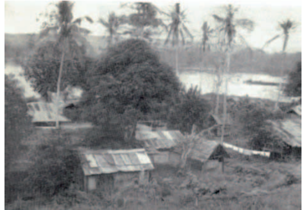
Manokwari: voorlopige kolonistenwoningen, die uit rond hout werden opgetrokken, de dakbedekking is voornamelijk van oude verroeste golfplaten.
